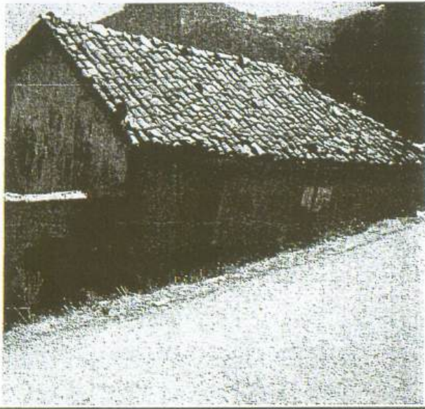
Konutlarda gözlemlenen geriye yatmalar, sapmalar ve yollardaki deformasyonlar
